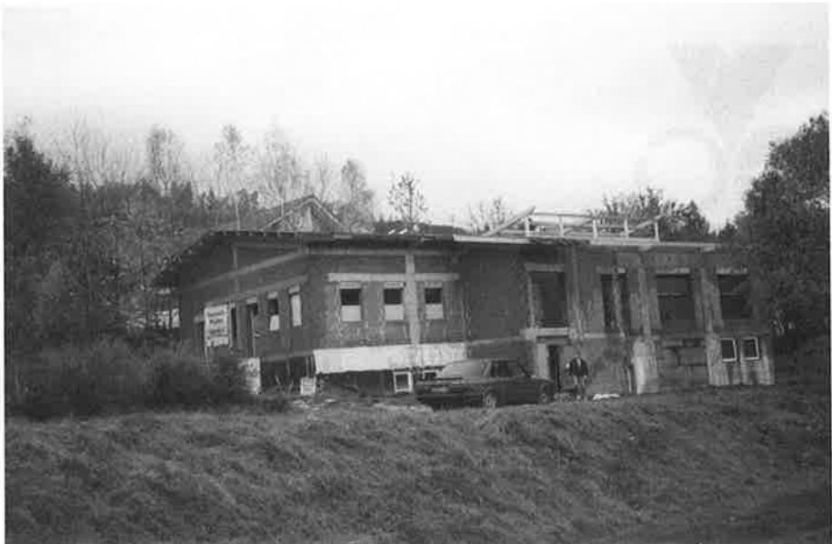
Der Rohbau steht ! (Fotos: Karl Zeller)
